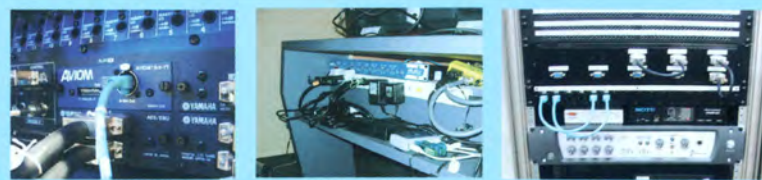
YAMAHA O2R96に実装されたAviom 16/o-Y1ヤマハアウトボード コントロールルームのファニチャー内に納められたAN-16/o マシーンルーム内のEtherパッチ (青ケーブル)
