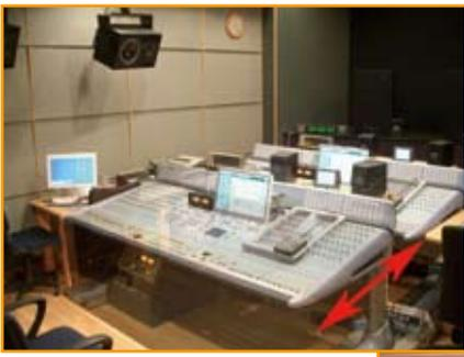
従来から ProTools を利用いただいている SC アライアンス様ですが、この度の改修で ICON コンソールを導入されました。このスタジオの最大の特徴は、コンソールが前後に約 3m 移動できる事で、ミキシング時は、サラウンドのスイートスポット（最適リスニングポイント）をコンソールセンターに置き、最終的な、クライアントの試聴時には、ICON 一式をリアーに移動し、その位置が試聴室に変身する画期的なスタジオです。又スピーカー位置もボタンを使い自由に移
